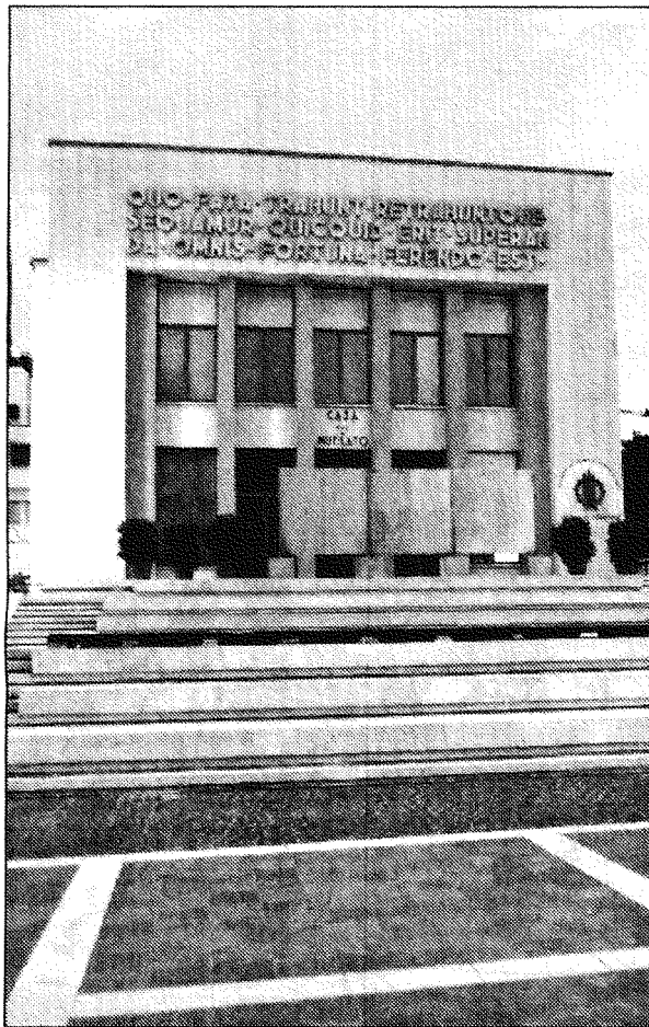
La Casa del mutilato in piazza XX Settembre
